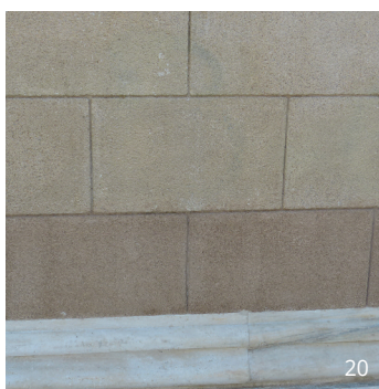
20. Λεπτομέρεια της τοπικής συμπλήρωσης του επιχρίσματος αρτιφισιέλ. Detail of localized repair of the artificial coating.
